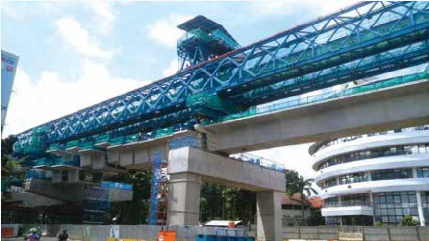
インドネシア・ジャカルタ地下鉄 (MRT) 工事風景
