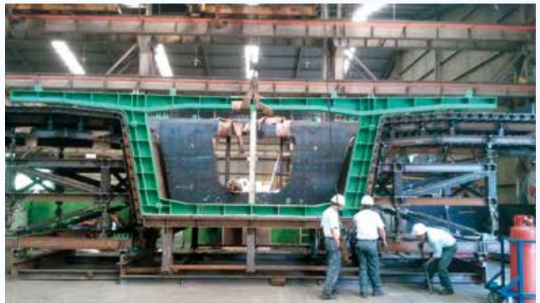
インドネシア地下鉄 (MRT) 高架橋用型枠
